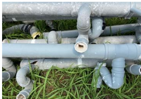
污水管道现状
